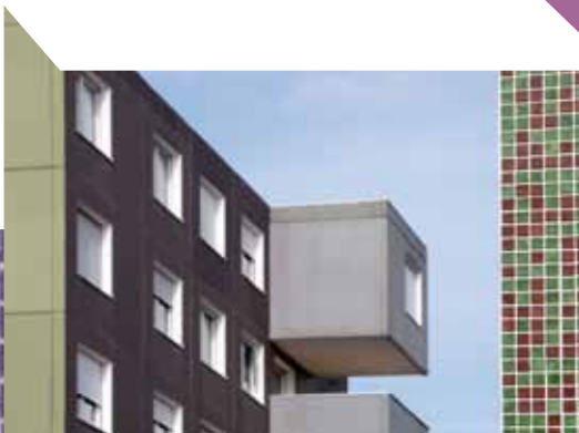
Immeuble boulevard des Herbues
